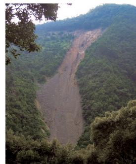
崩壊した作業道
